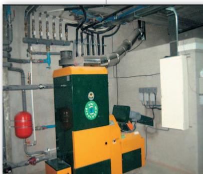
Figura 34: Instalación mixta de biomasa y solar térmica en pabellón de deportes.
