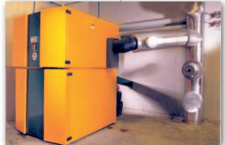
Figura 33: Caldera de pellets de 150 kW.
