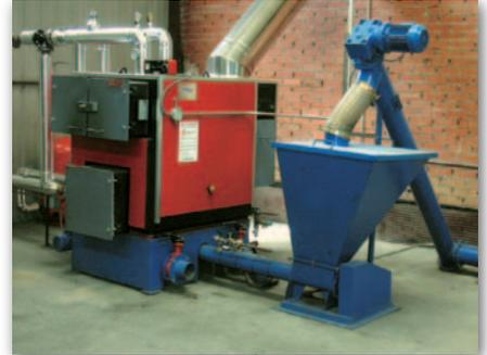
Figura 32: Caldera de pellets (admite otros combustibles) de 250 kW de potencia.
